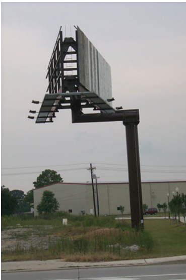
Het gewicht van dit verkeersbord en de windbelastingen die erop werken veroorzaken normaal- en afschuifkrachten en buig- en wringmomenten in de dragende kolom.
